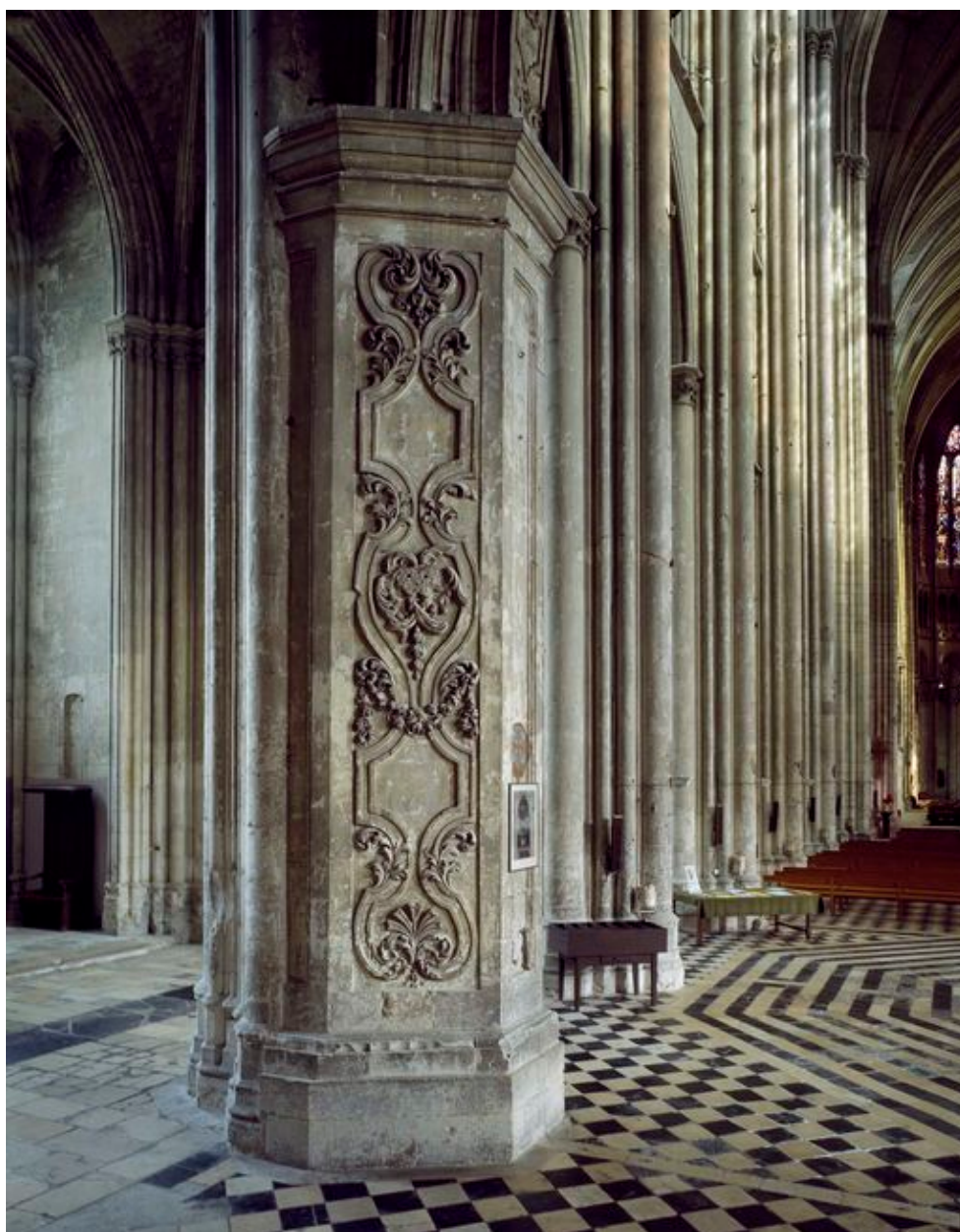
Vue d'un pilier de la tribune.
