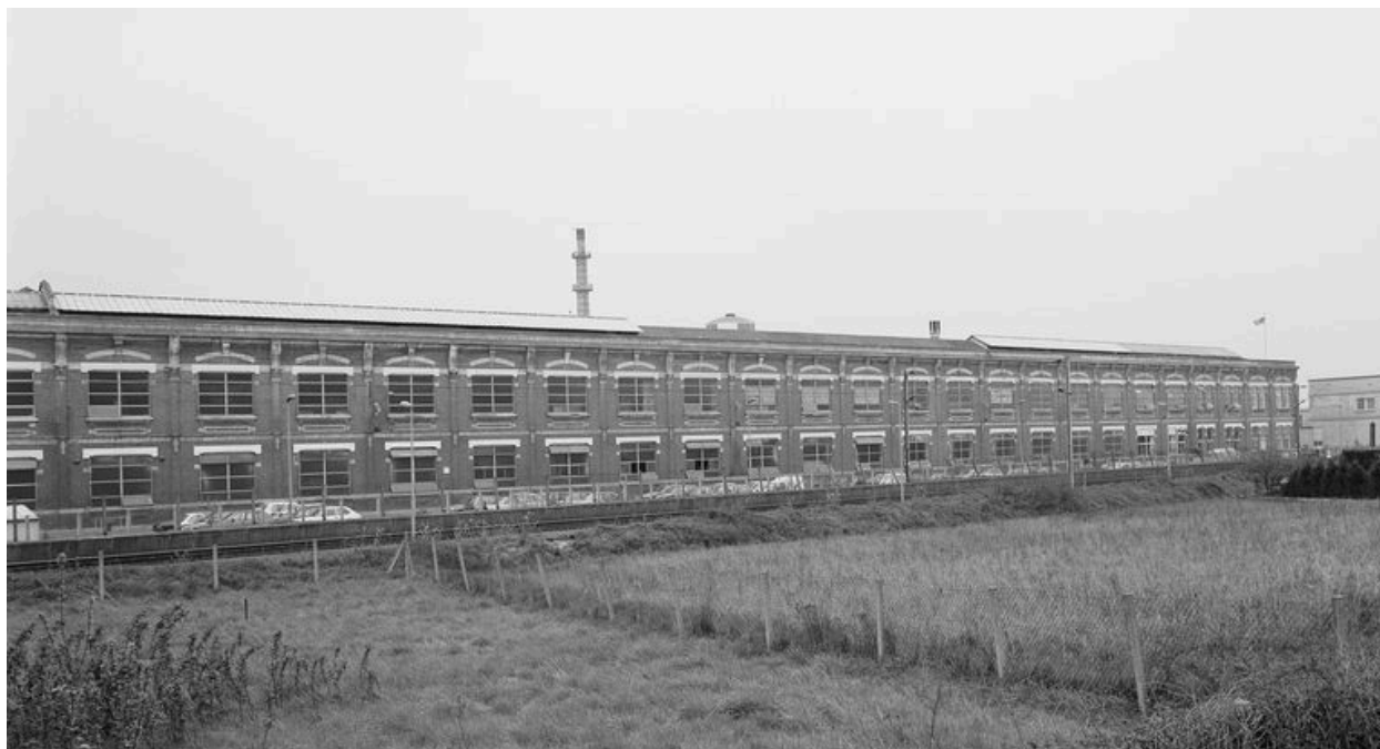
Atelier de fabrication ouest, vue partielle.
