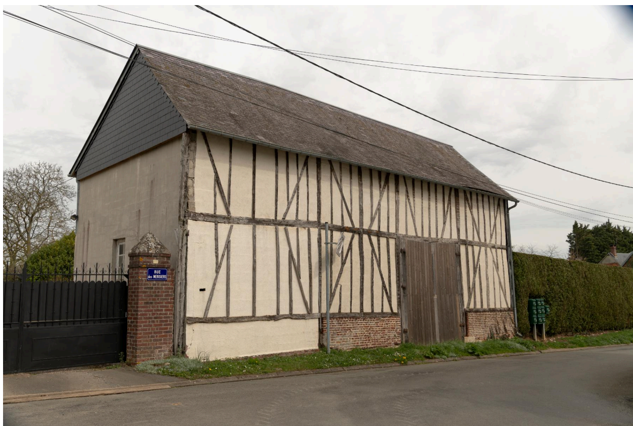
Grange n°228 rue des Merisiers, vue depuis le sud.
