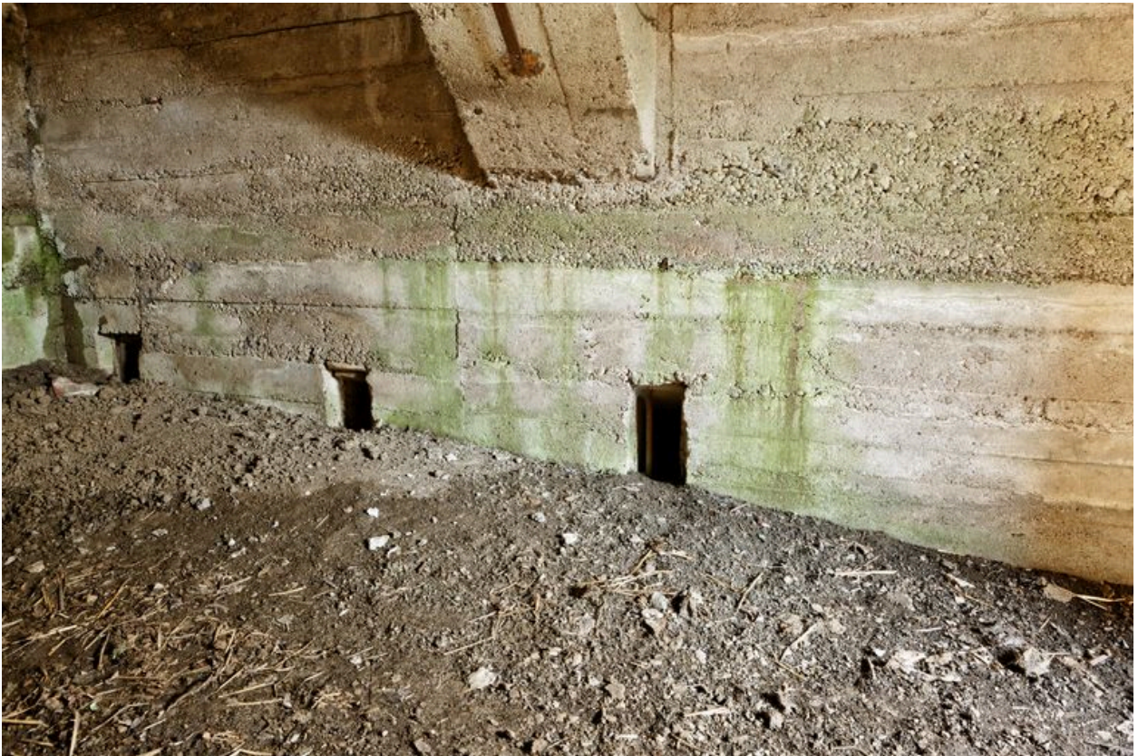
Salle secondaire, ouvertures à la base du mur est.
