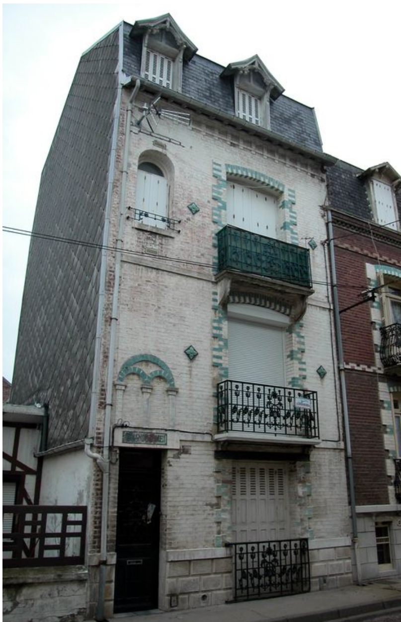
Vue d'ensemble depuis la rue.
