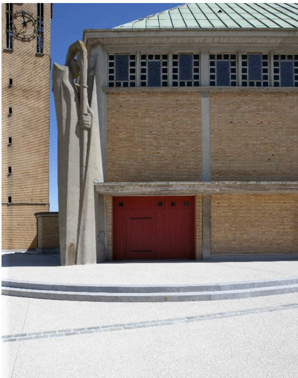
Entrée flanc sud de l'église.
