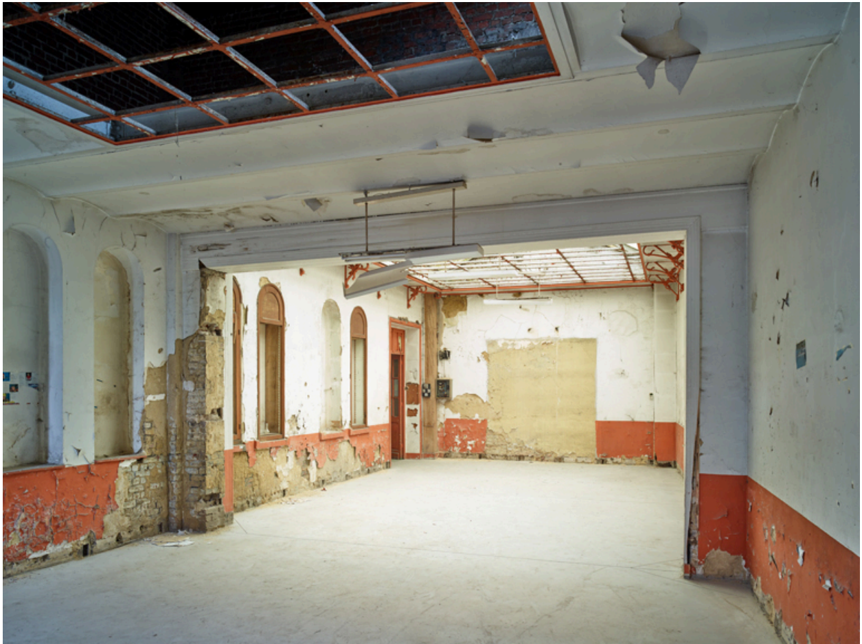
Bâtiment technique, rez-de-chaussée. Vue vers l'ouest.
