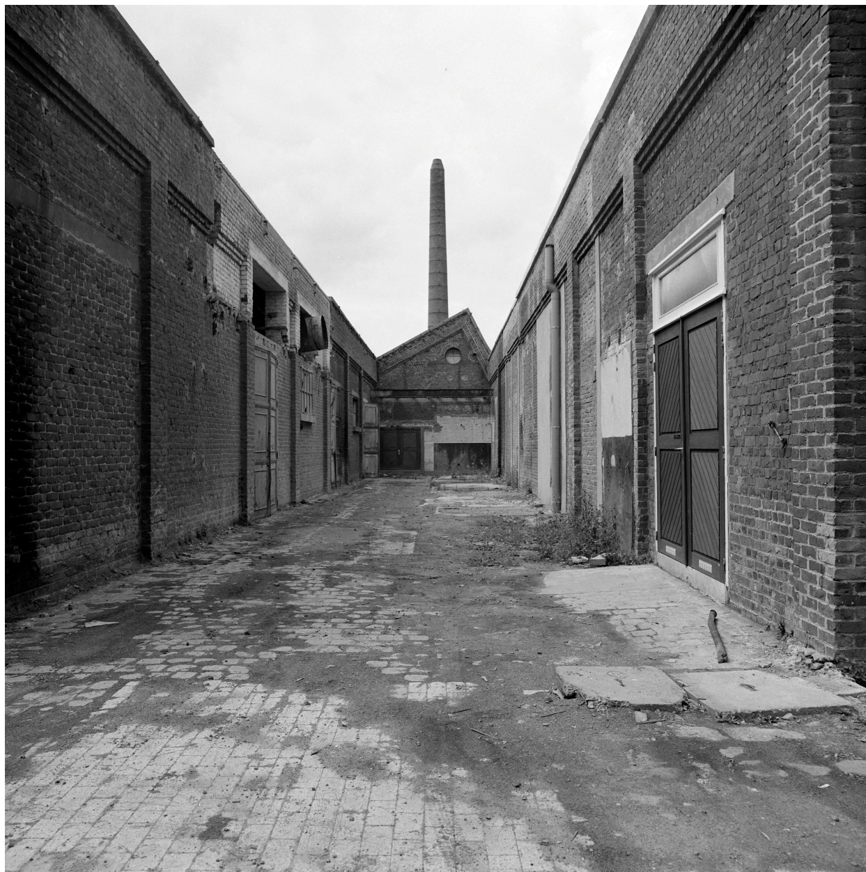
Emplacement de l'ancienne chaufferie. Vue prise vers l'ouest.
