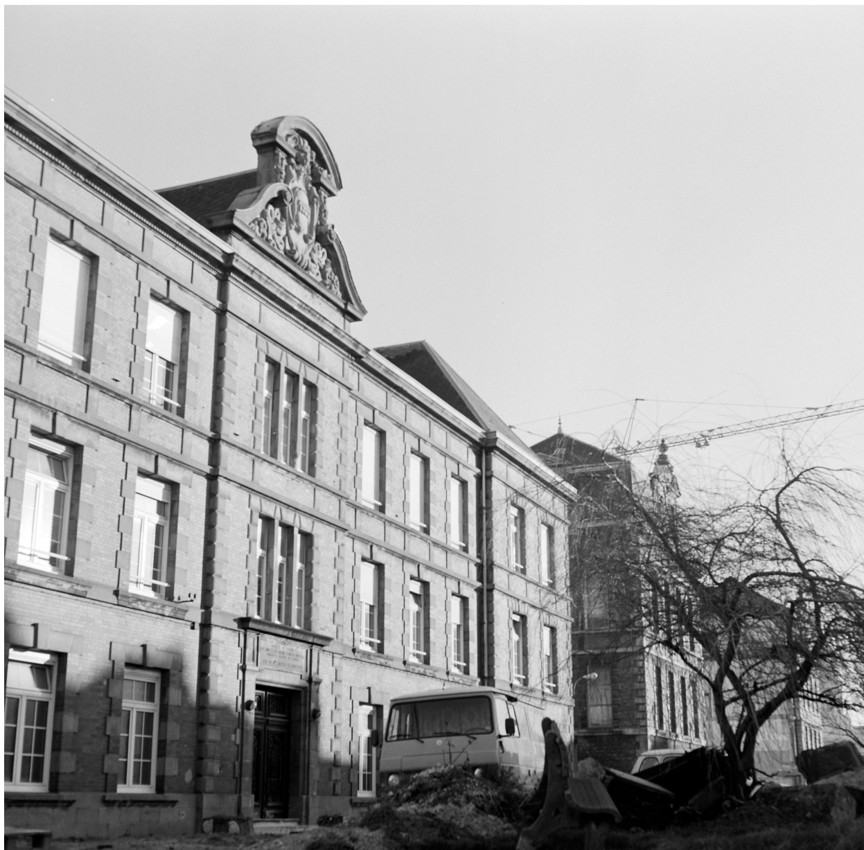
Bâtiments 1, 2, 3 : vue d'ensemble rue Louis Duflos.
