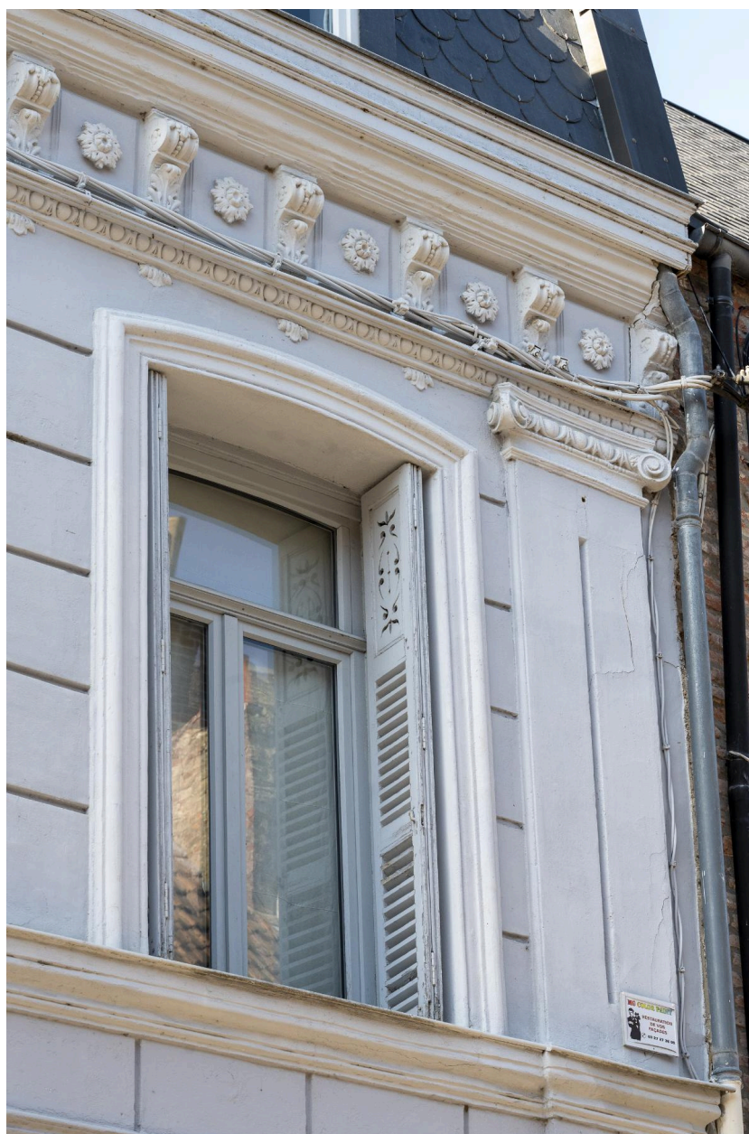
Maison de maître - 5, rue Chevray : détail du décor porté sur la corniche sommitale.
