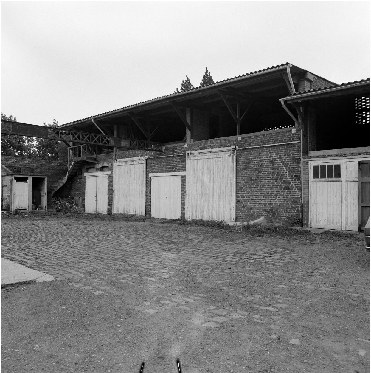
Magasins industriels sur cour.
