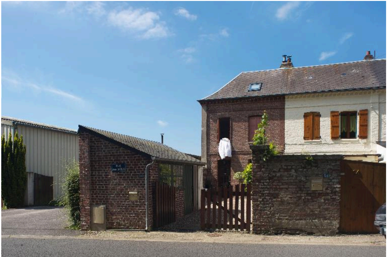
Détail d'un des logements de la cité ouvrière et de sa boutique.
