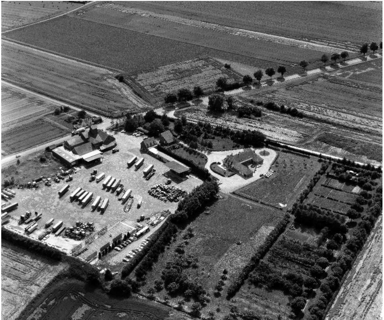
Vue aérienne, flanc nord-est.
