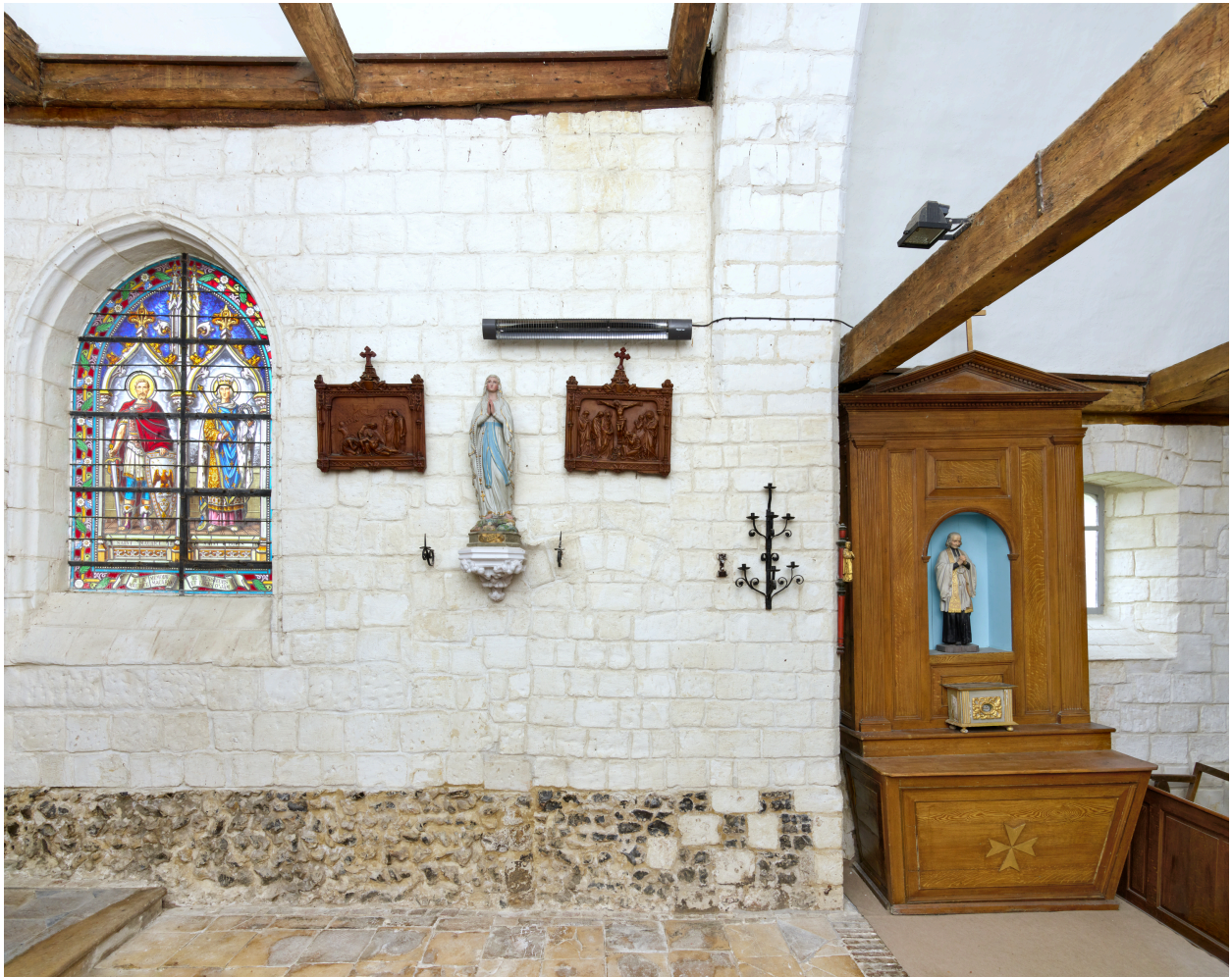
Intérieur, détail de la maçonnerie du mur sud du chœur.
