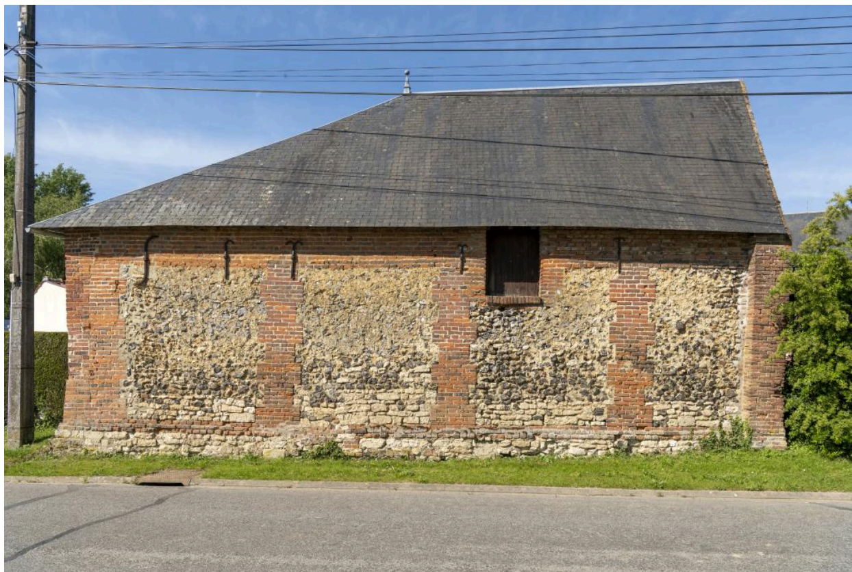
Façade sud d'un bâtiment agricole, vue depuis la rue Principale.
