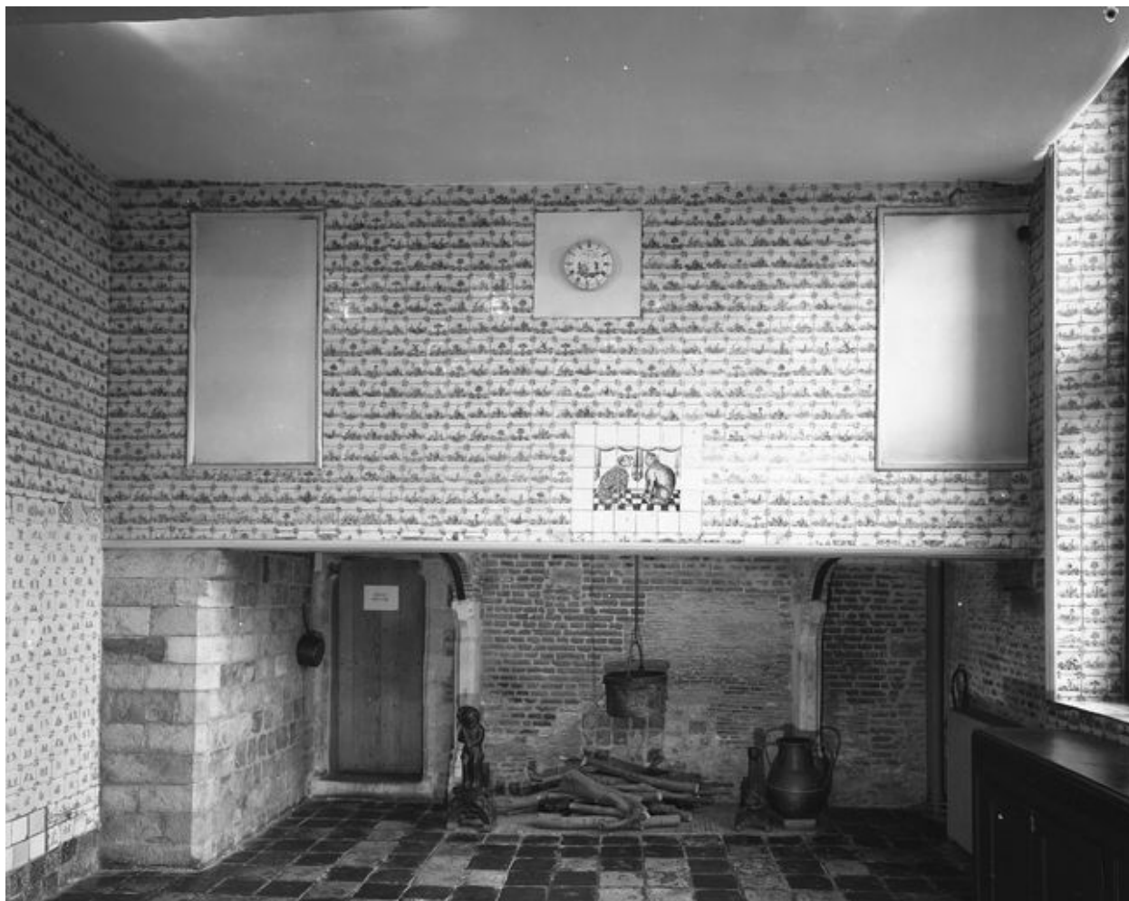
Bâtiment de la communauté religieuse, rez-de-chaussée, ancienne cuisine, cheminée, vue générale.
