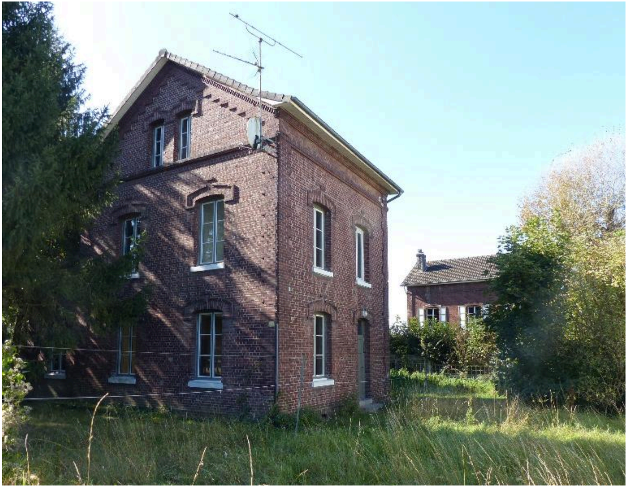
Les maisons des chefs de train. Premières maisons de la cité construites vers 1910.
