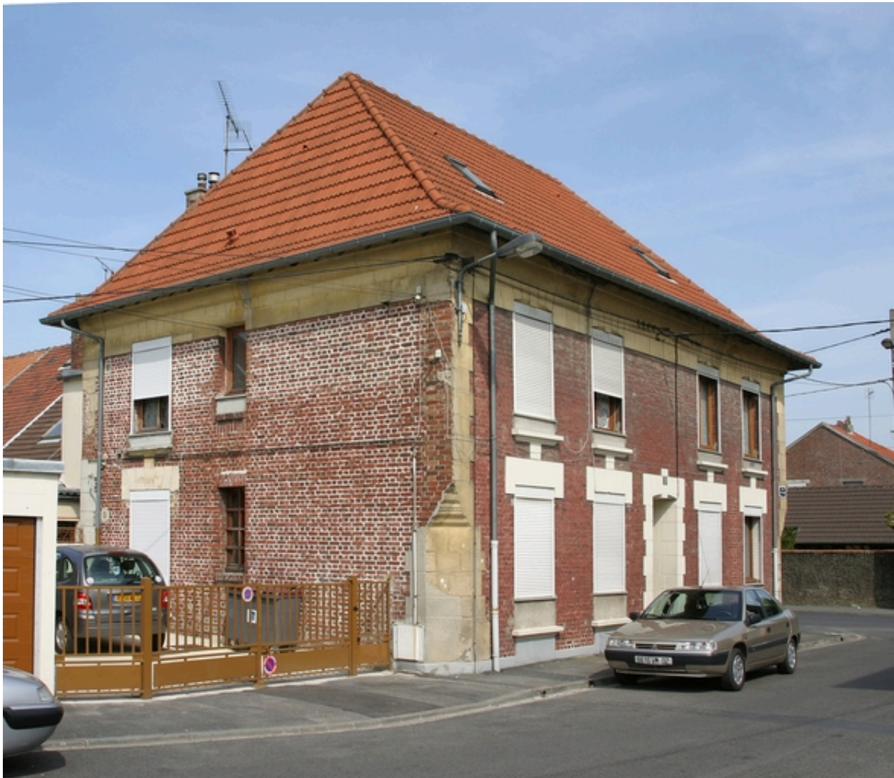
Pavillon d'entrée, à l'angle de l'allée des Rosiers et de la rue de Vermand.
