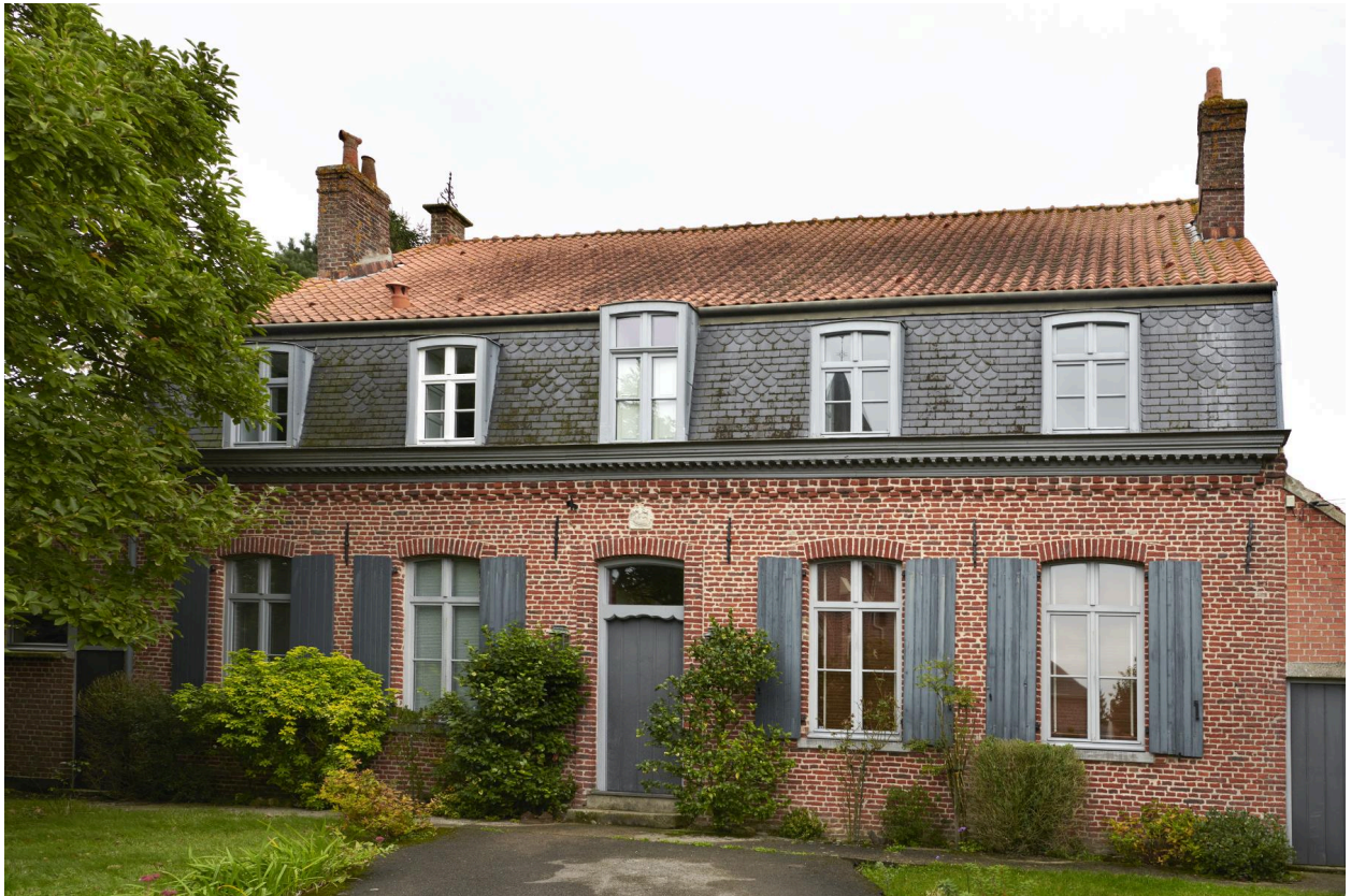
Façade principale (ouest).
