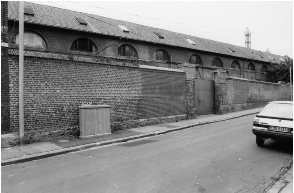
Ateliers de fabrication, flanc sud-ouest.
