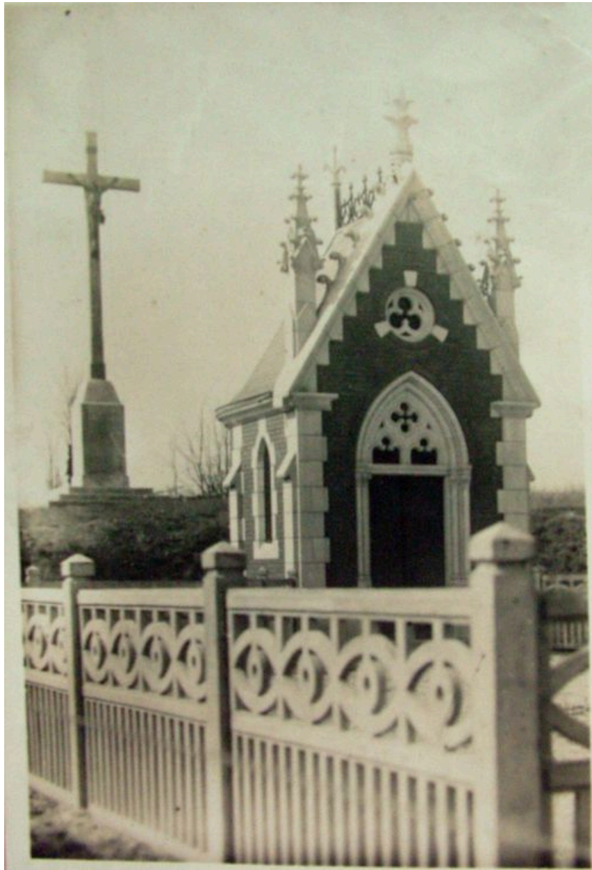
Vue générale de l'édifice après son édification (Archives Diocésaines).
