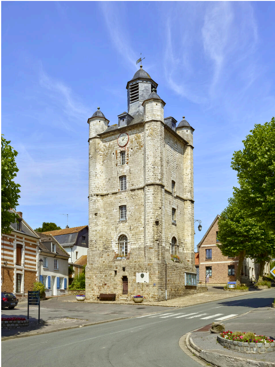
vue d'ensemble du beffroi depuis le sud.
