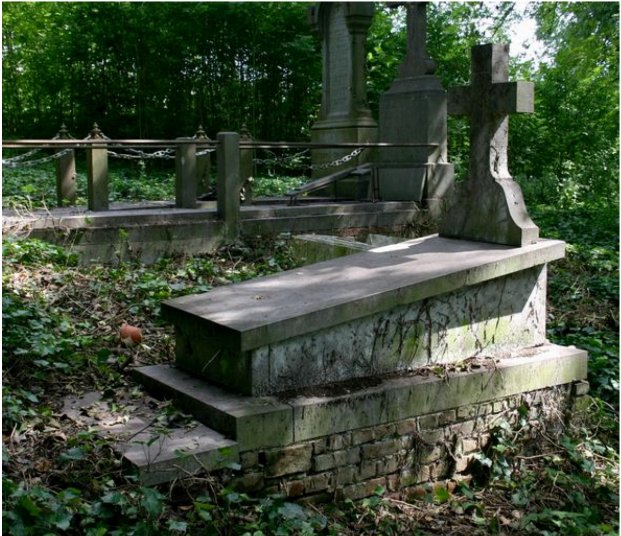
Vue générale, depuis le côté.
