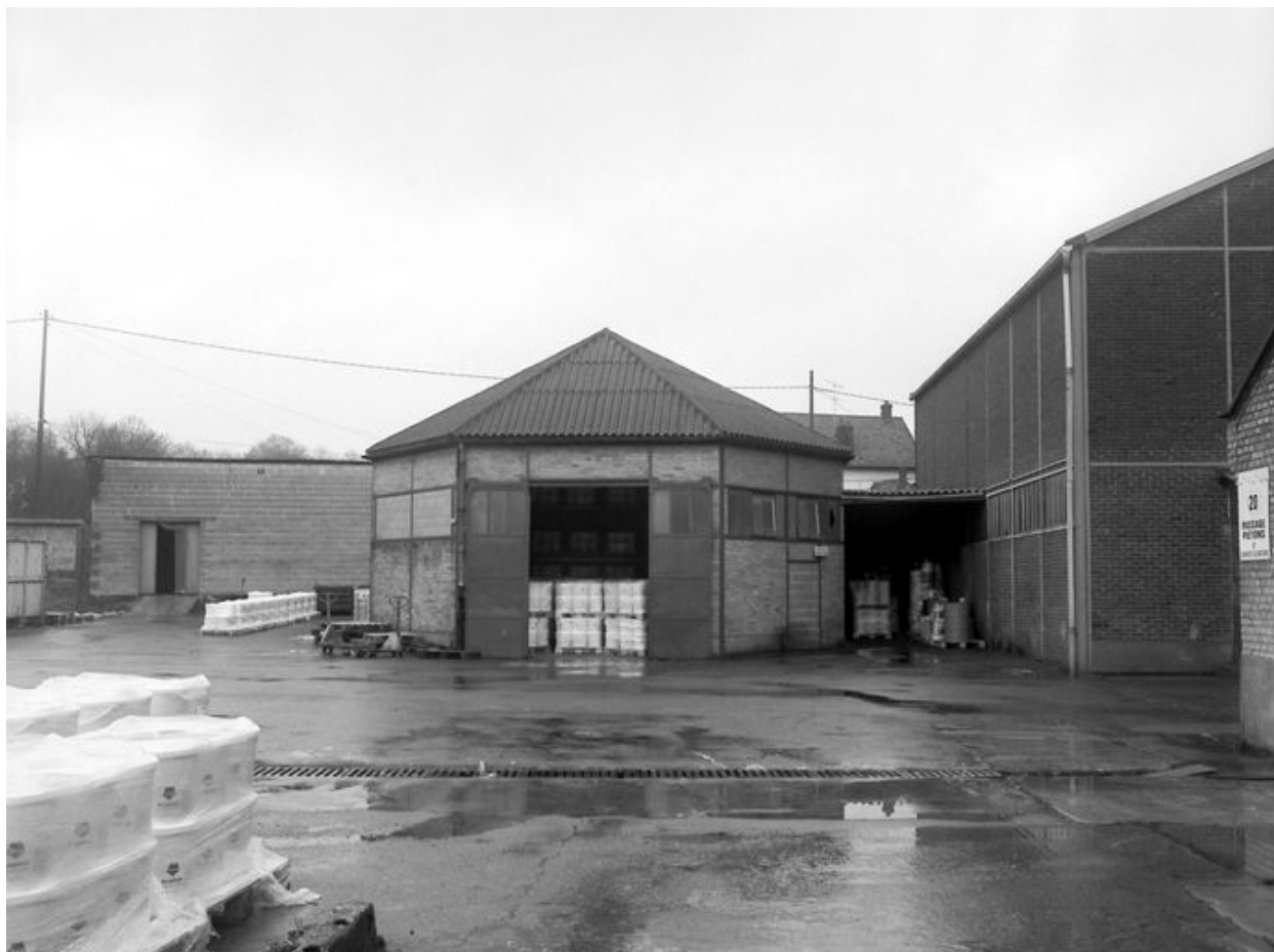
Magasin industriel, pignon est.
