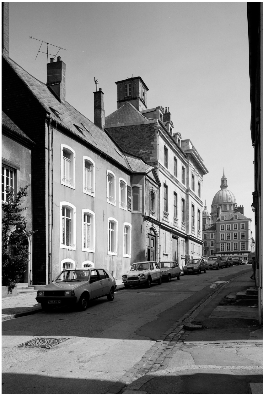
Vue d'angle sud-ouest.
