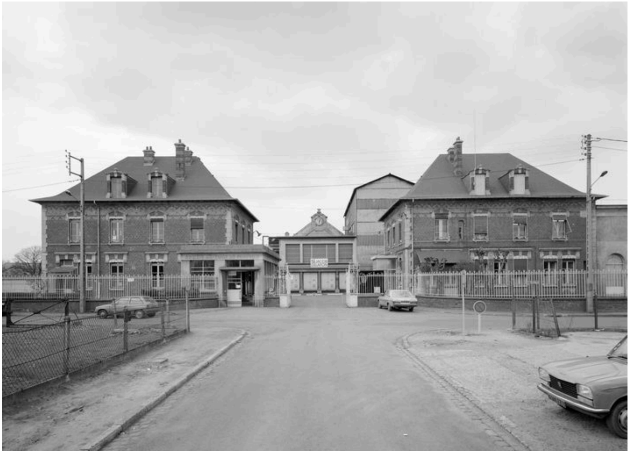
Vue générale des bâtiments d'entrée.
