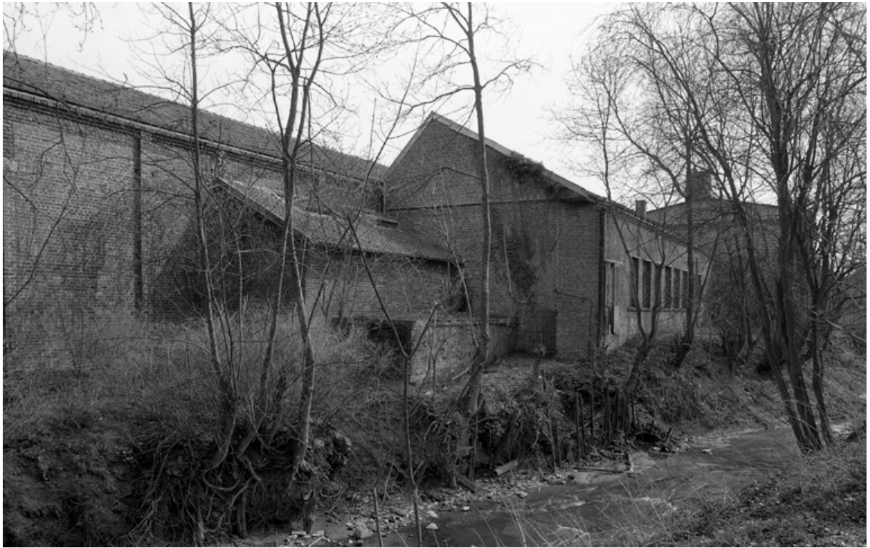
Vue partielle des bâtiments au sud de l'usine.
