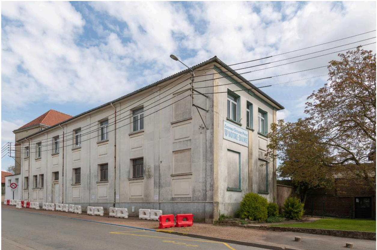
Façade principale de l'extension sur la rue du Général-Frère et façade latérale sur la rue d'Arras.
