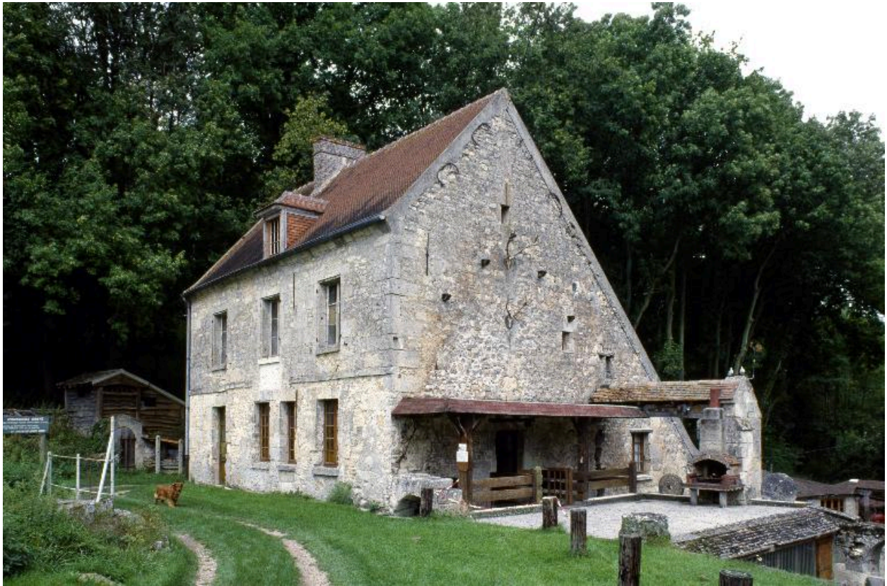
Vue du moulin depuis le sud-ouest.
