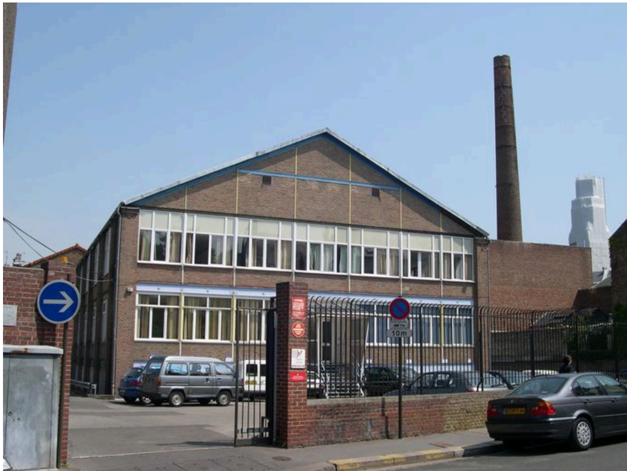
Vue depuis la rue Pierre-Lhermite, au sud.
