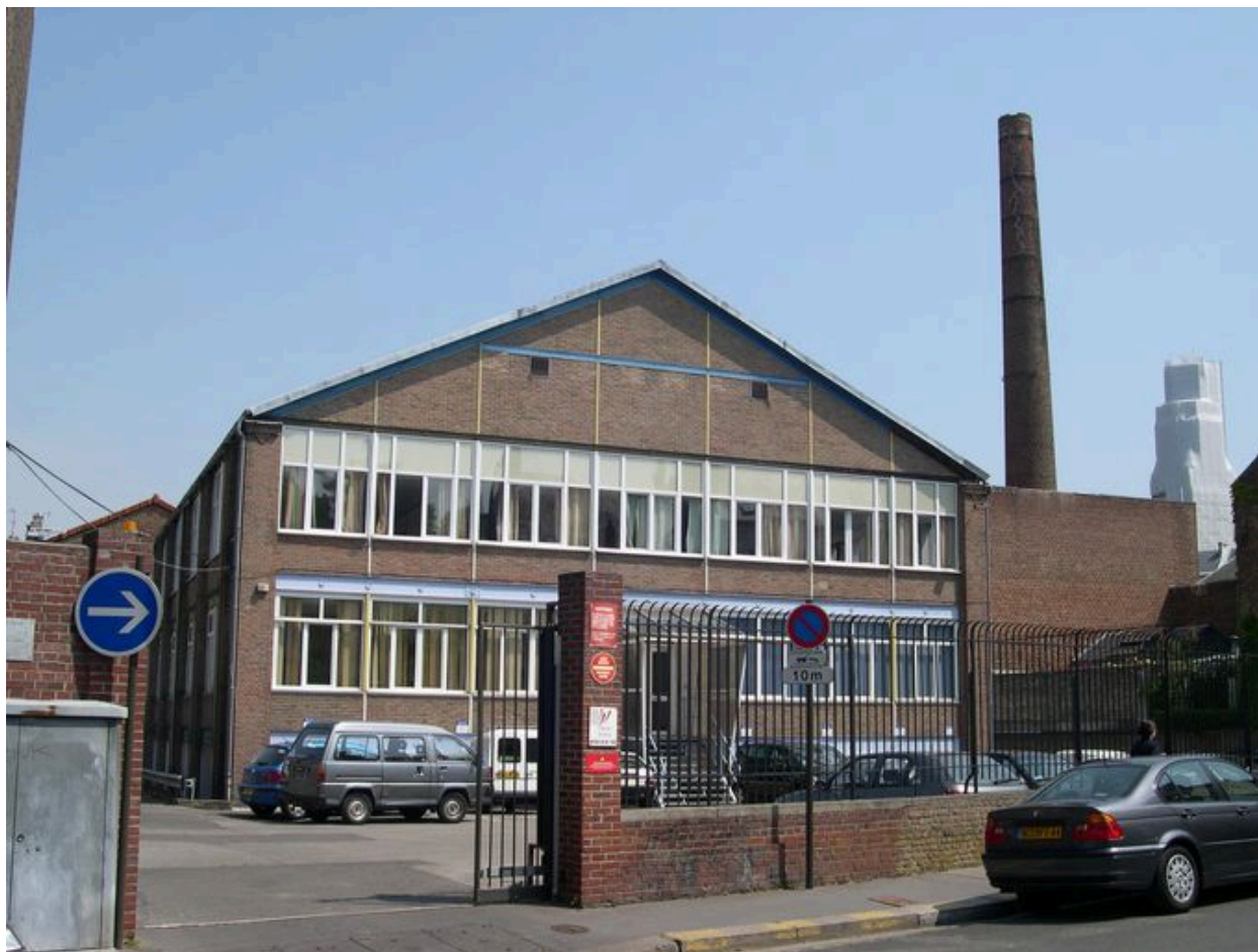
Vue depuis la rue Pierre-Lhermite, au sud.
