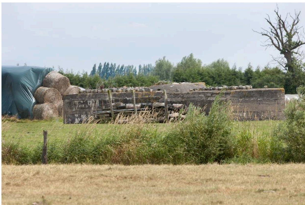
Vue générale, vers le sud-est
