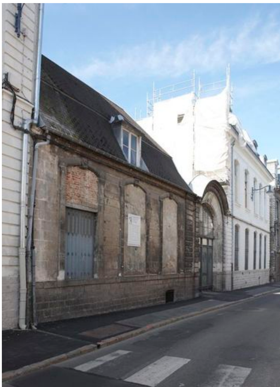
Vue générale. Hôtel en restauration
