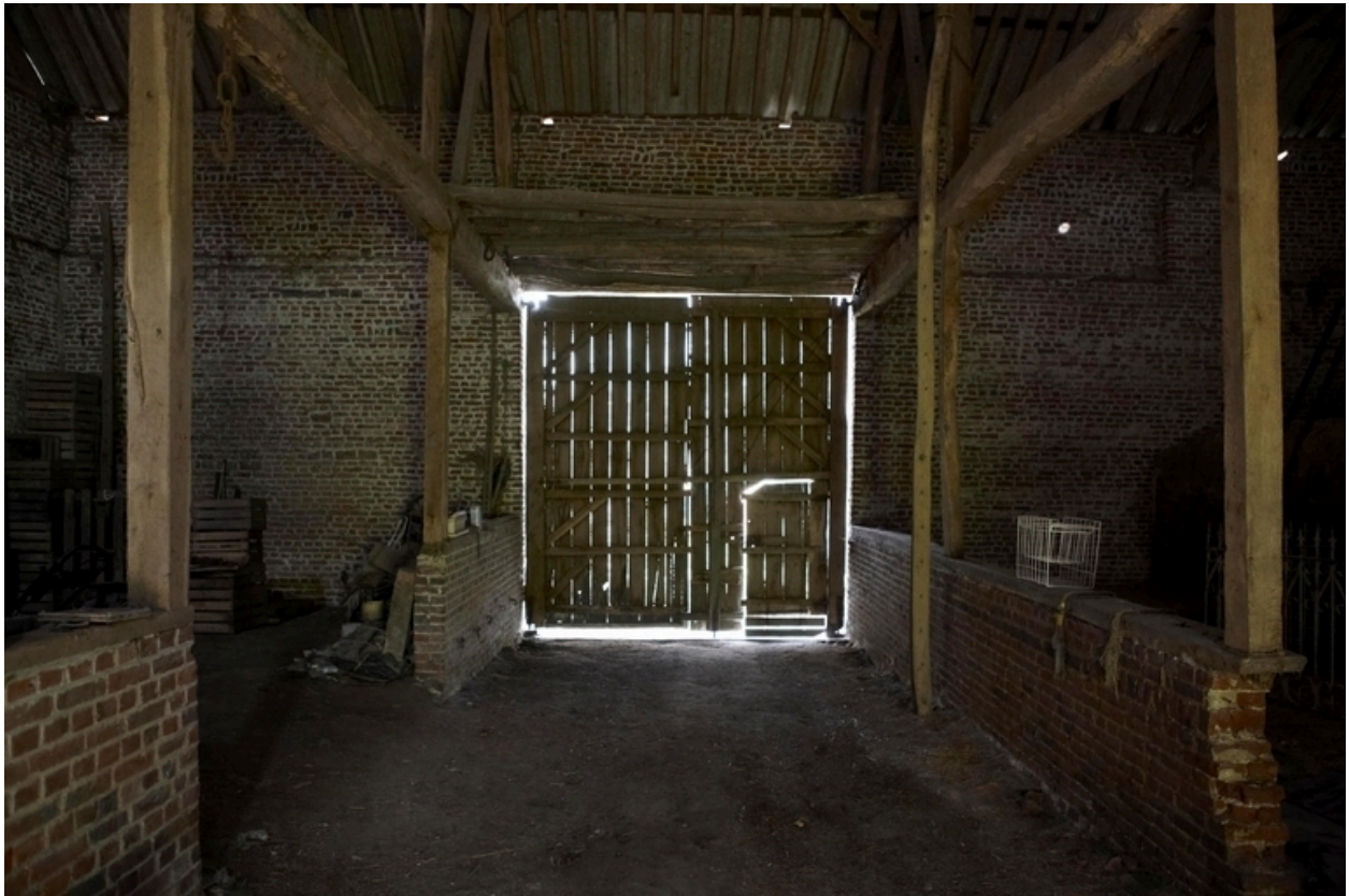
Vue intérieure de la grange.
