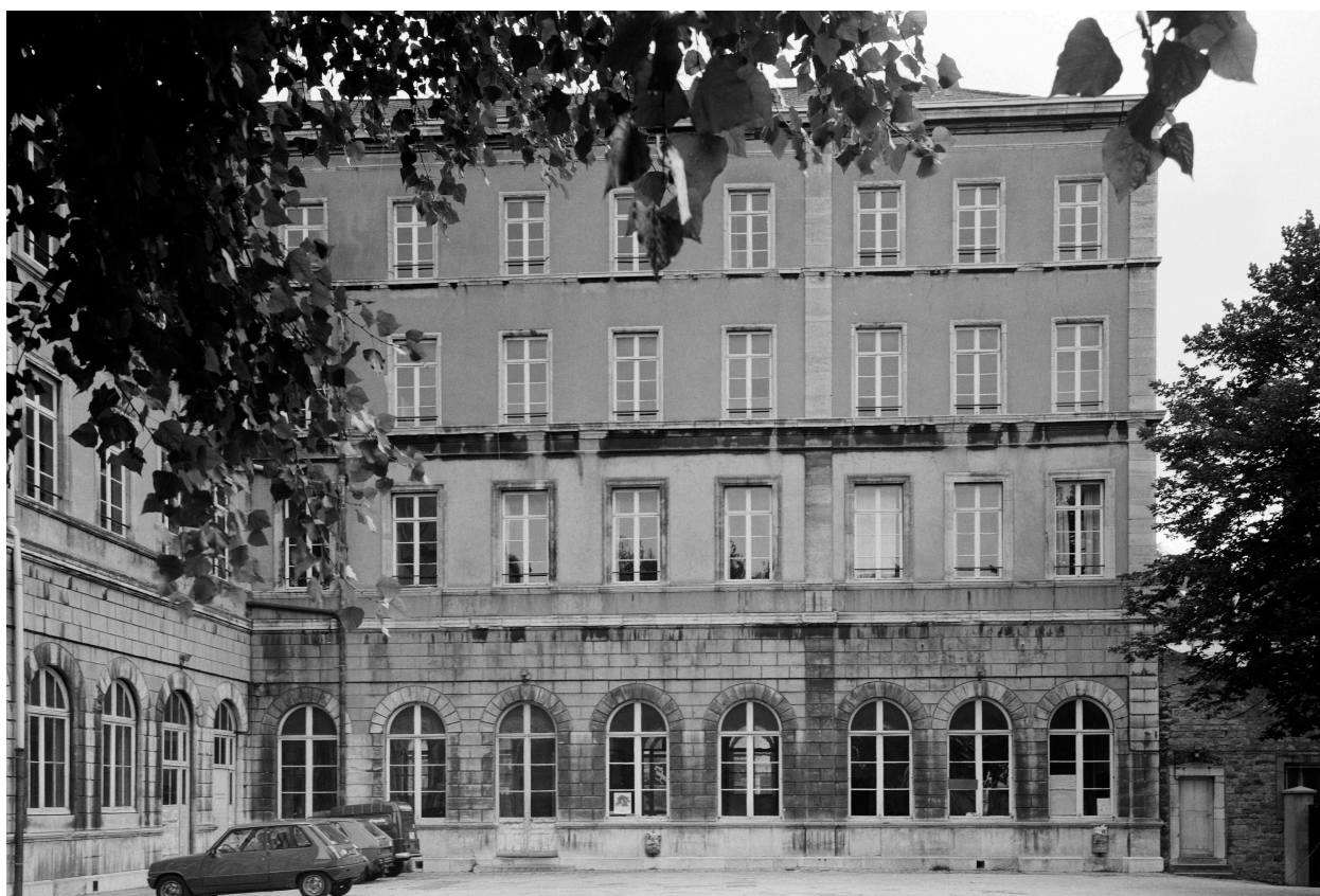
Rue des Pipots, bâtiment principal : façade sur cour.
