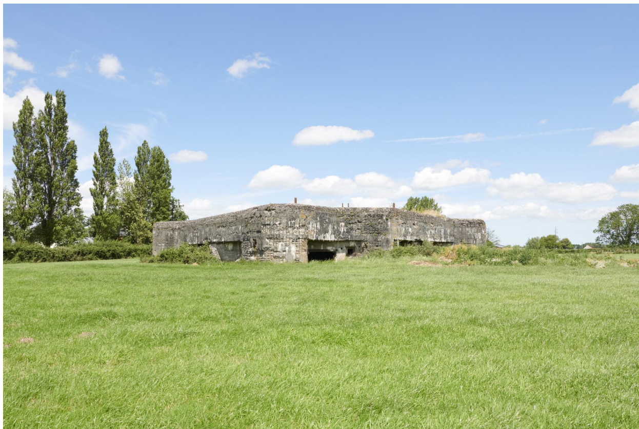
Vue du sud-est de la casemate.
