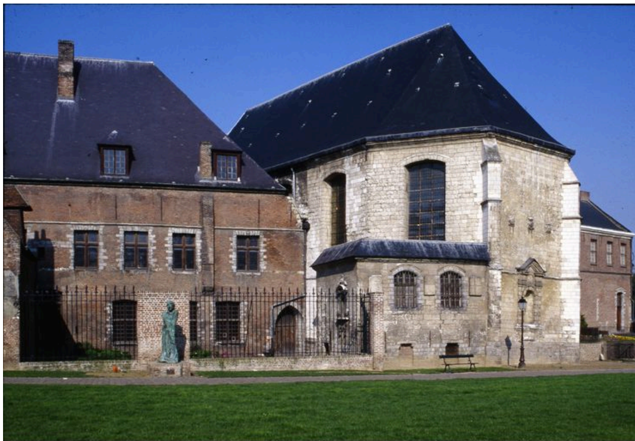
Élévation postérieure, face orientale, détail du chevet de la chapelle, vue prise de trois quarts gauche.
