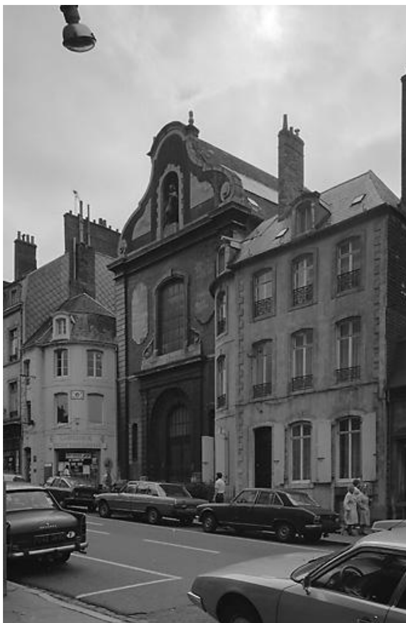
Chapelle, vue d'angle sur voie.
