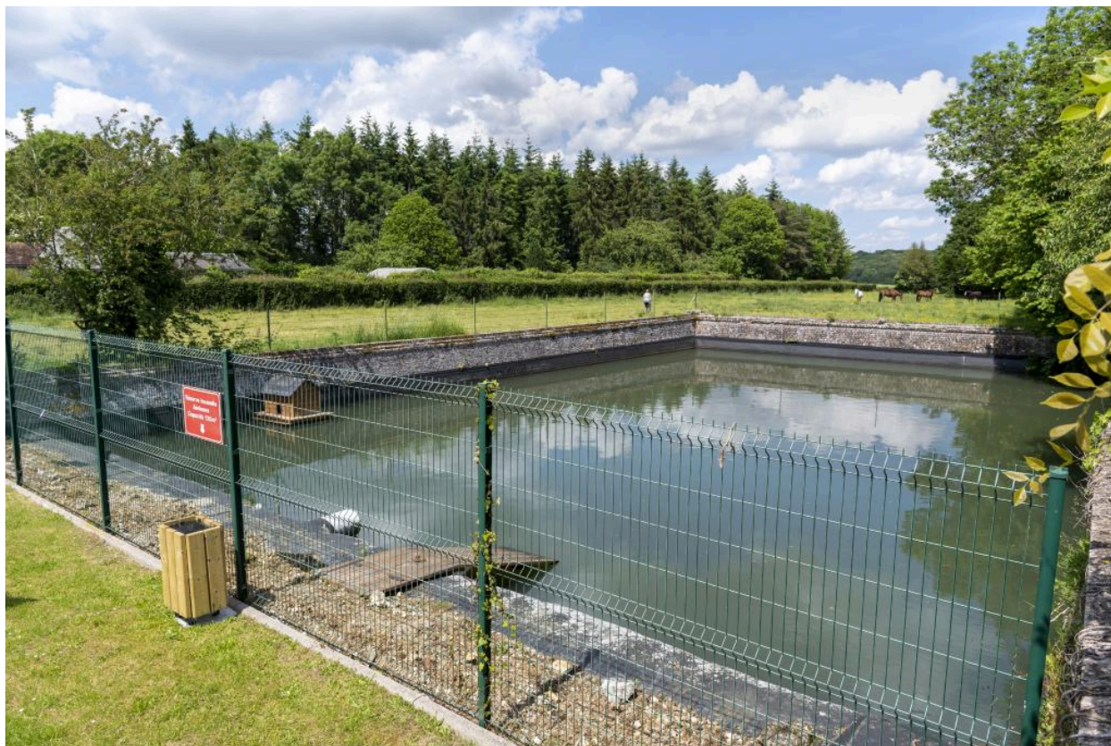
Mare, à côté du n°13 Grande Rue.
