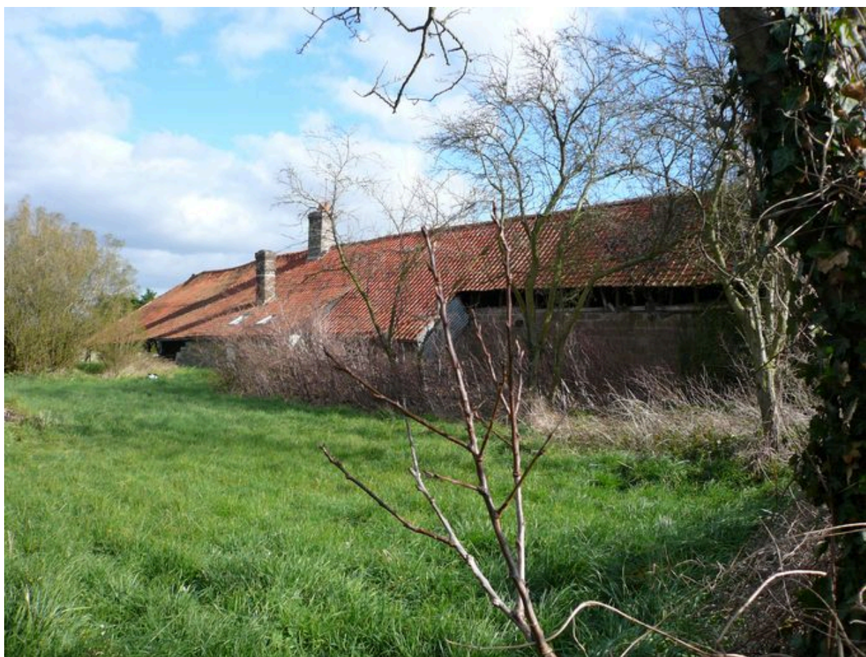
Vue postérieure du logis.
