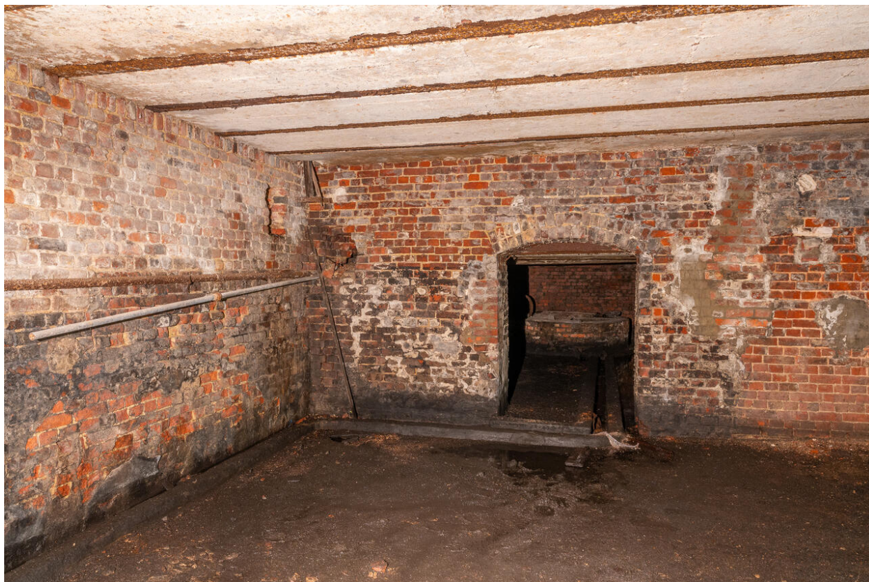
Sous-sol de la filature, vue de l'accès aux bassins-réservoirs.
