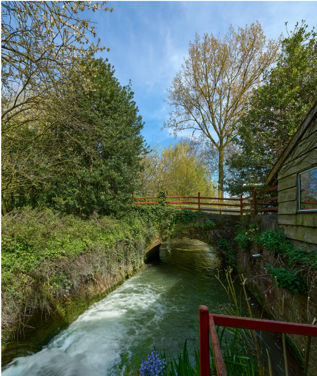
Vue depuis l'élévation nord du moulin vers le pont.
