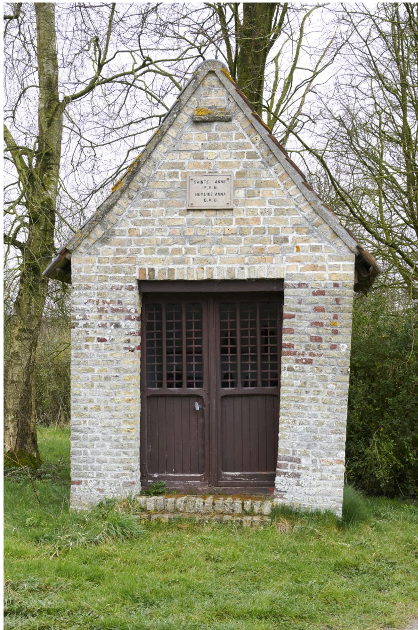
Façade principale de la chapelle.
