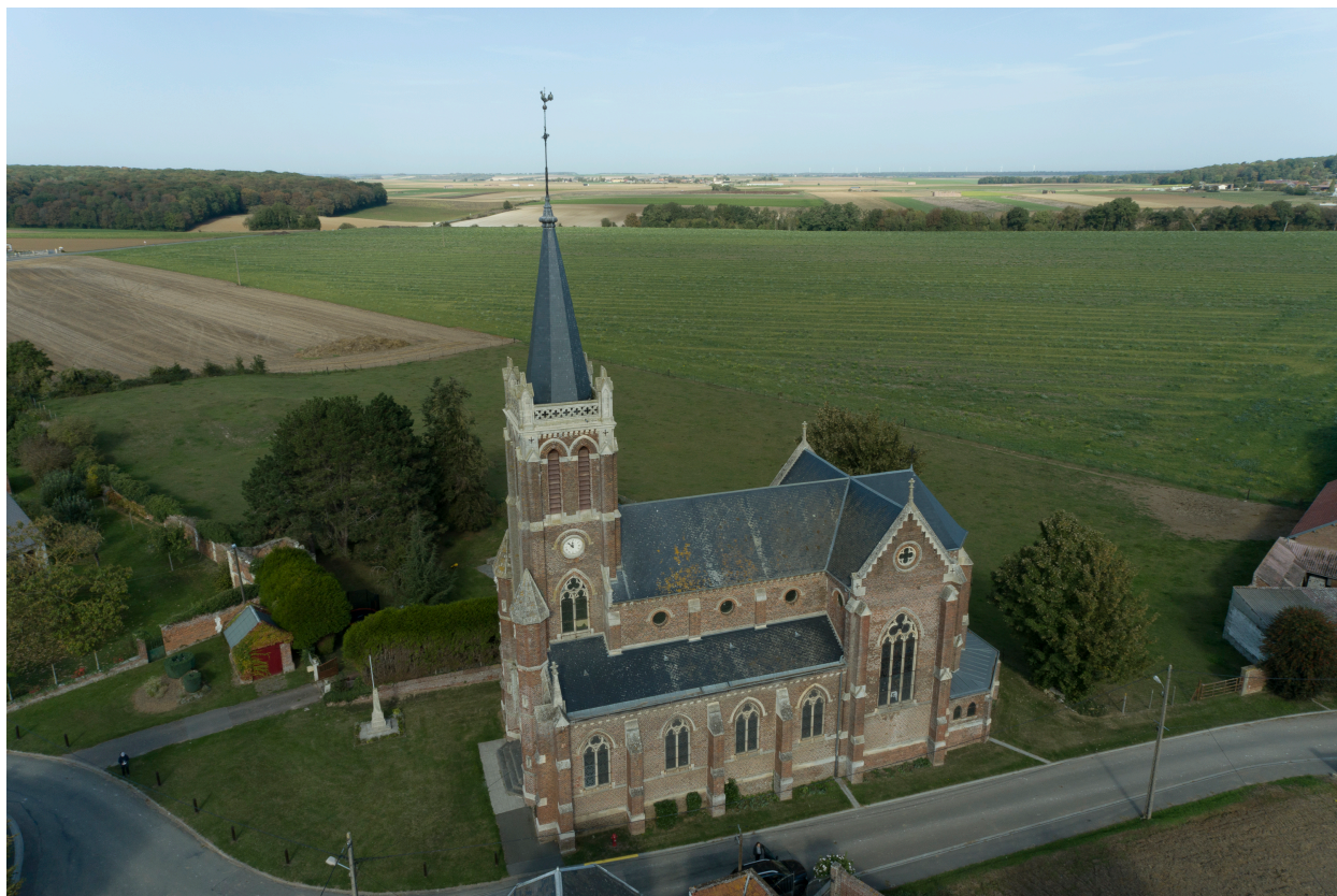
Vue aérienne de l'église depuis le sud-est.
