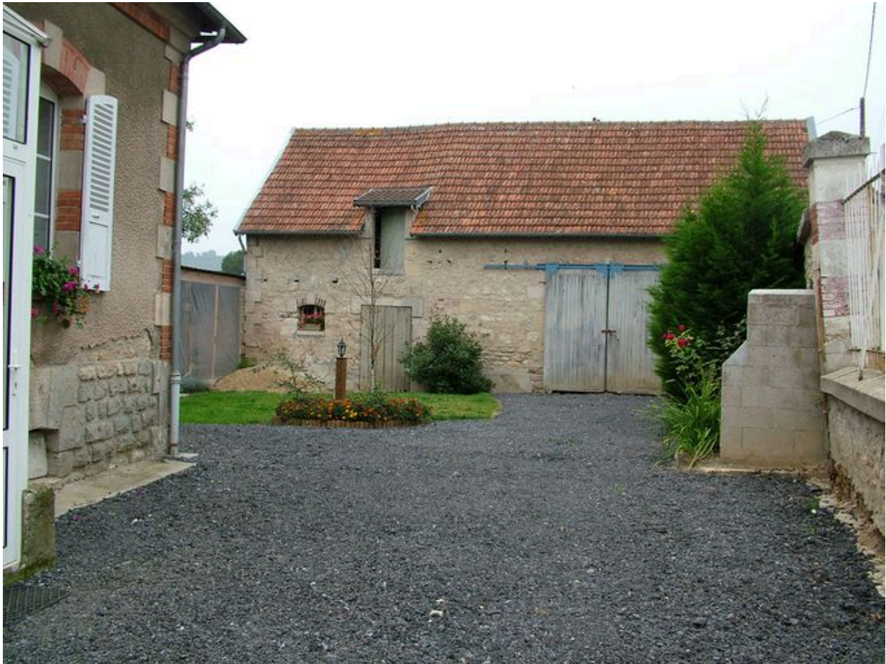
Vue de la grange.
