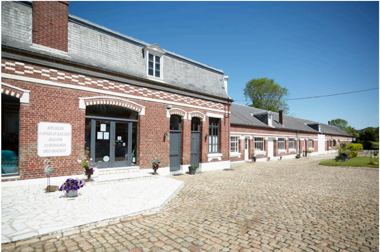
Vue des entrepôts situés à gauche de la cour depuis la rue du Faubourg de Péronne.
