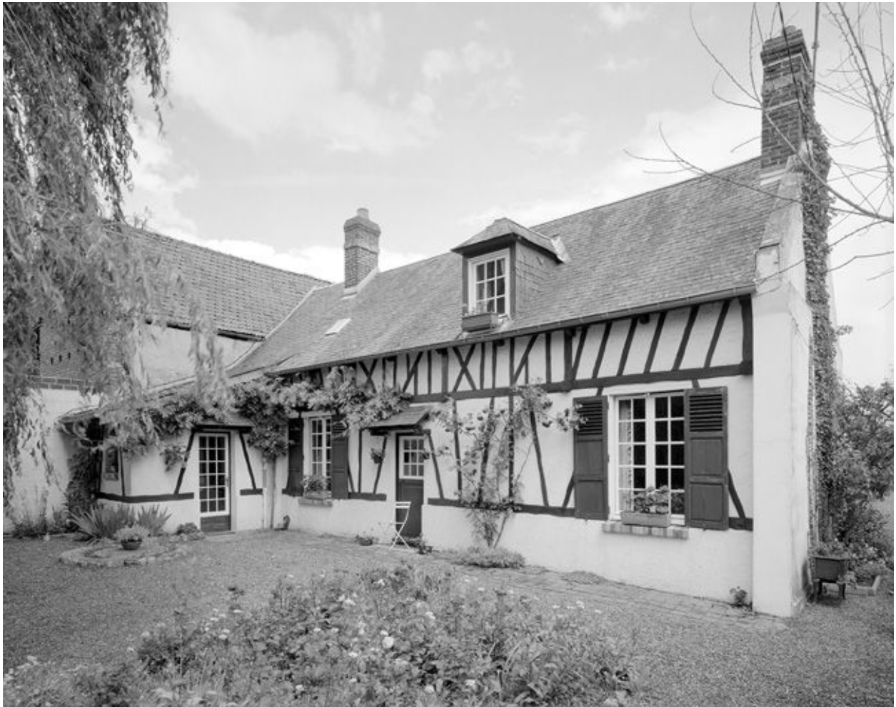
Logis. Vue générale.
