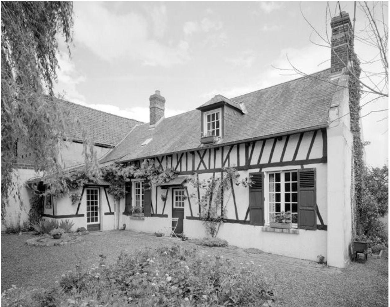
Logis. Vue générale.
