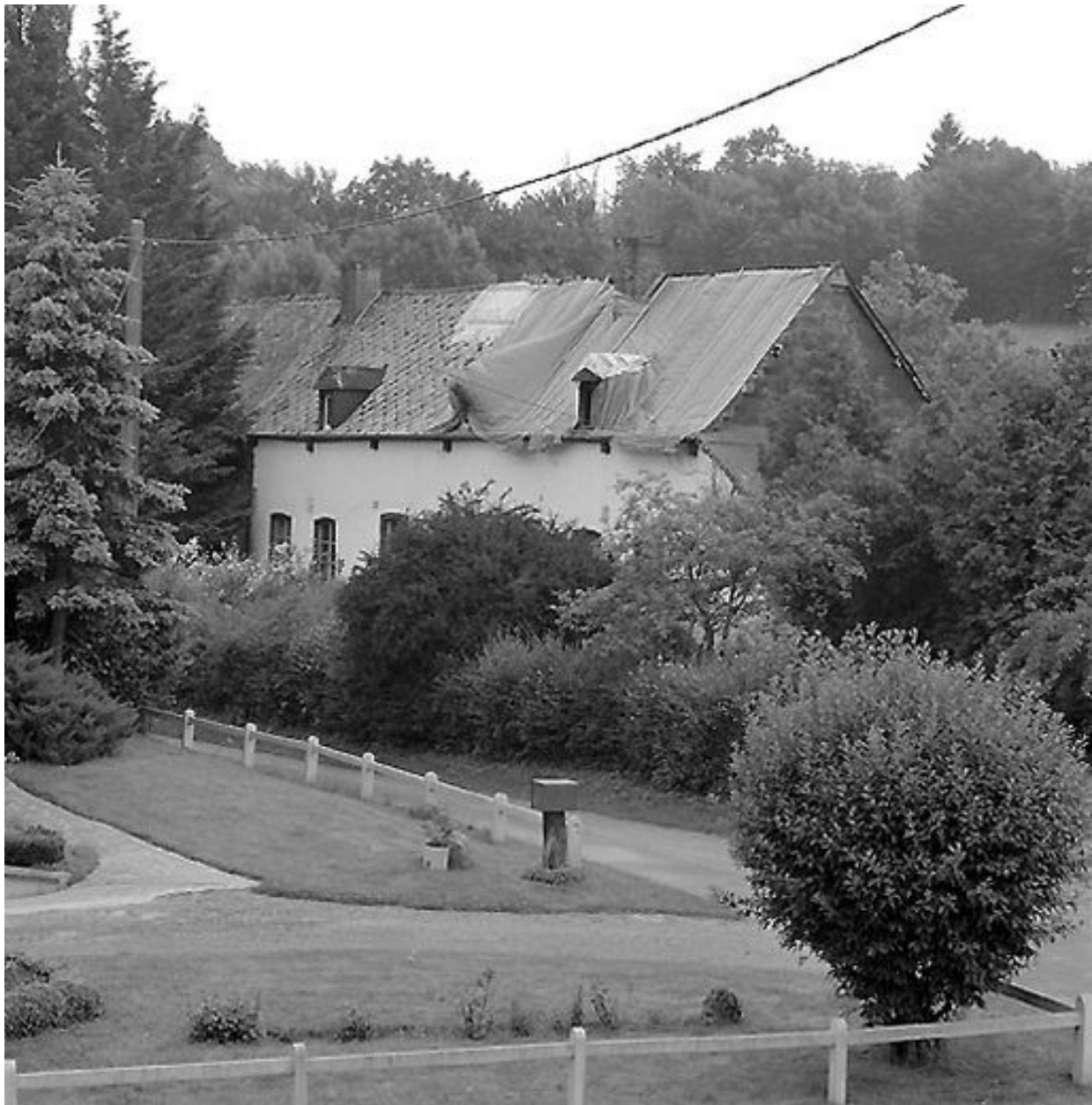
Vue éloignée du logis après sinistre.
