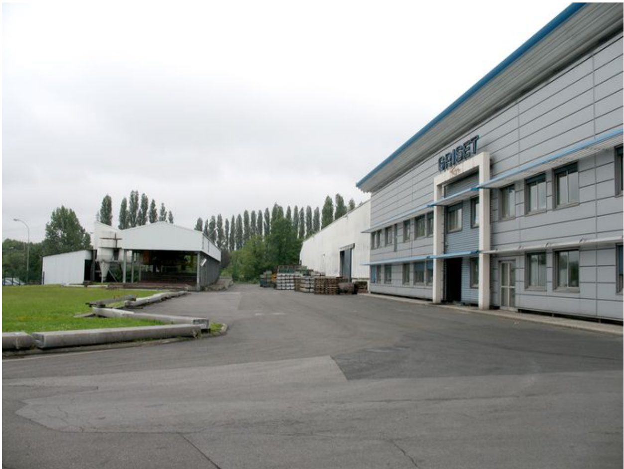
Le bâtiment administratif (au premier plan) et les hangars de stockage des métaux.
