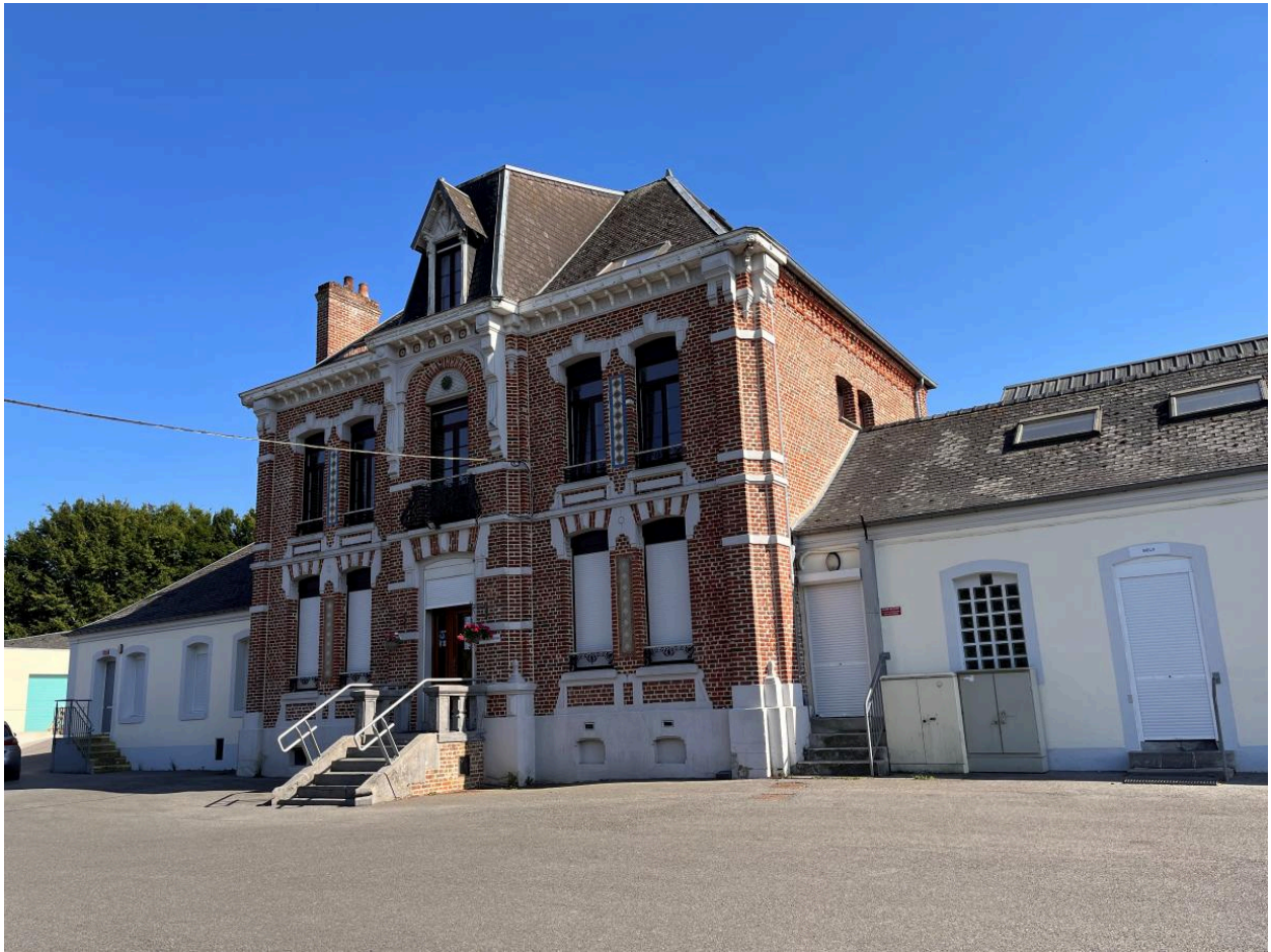
Le logement patronal, vue de trois-quarts.
