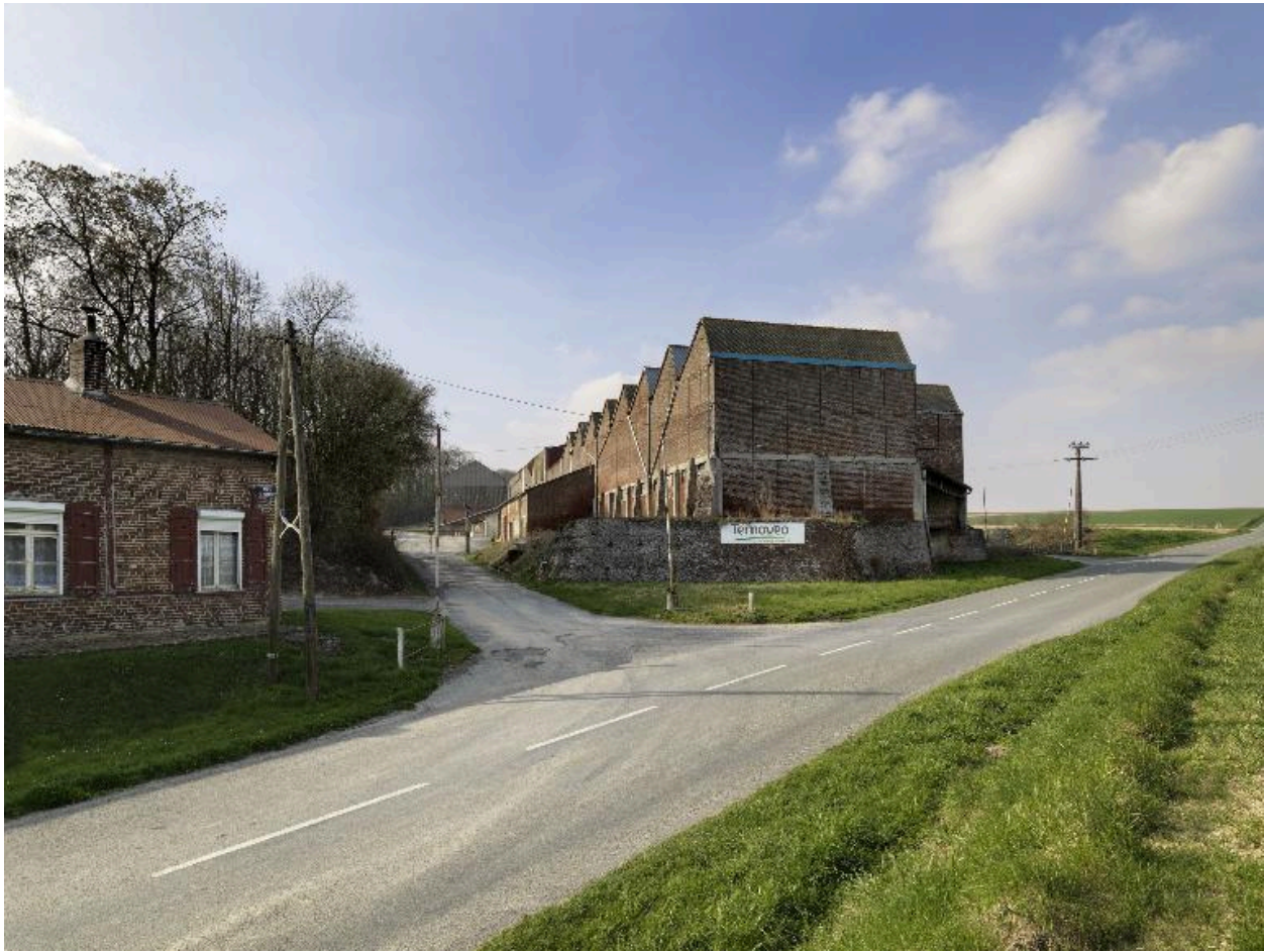
L'usine de phosphate depuis la route.
